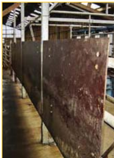
Parois pleines installées sur couloir de retour.
