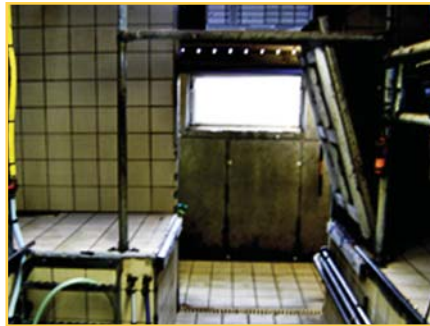
Fenêtre installée dans le couloir menant à la laiterie, au niveau du pont levé. D'après l'éleveur, les vaches marquent un temps d'arrêt à ce niveau.
