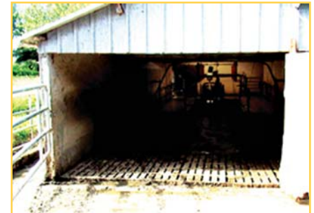
Contraste lumineux important entre l'intérieur et l'extérieur du bâtiment
